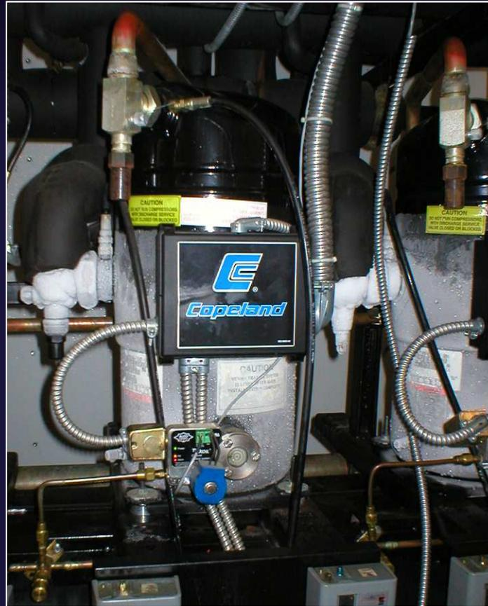
Excesivo retorno de refrigerante líquido puede ocasionar fallas por falta de lubricación
